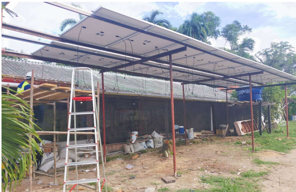
Figura 17 – Local escolhido para implantação do gerador fotovoltaico.
