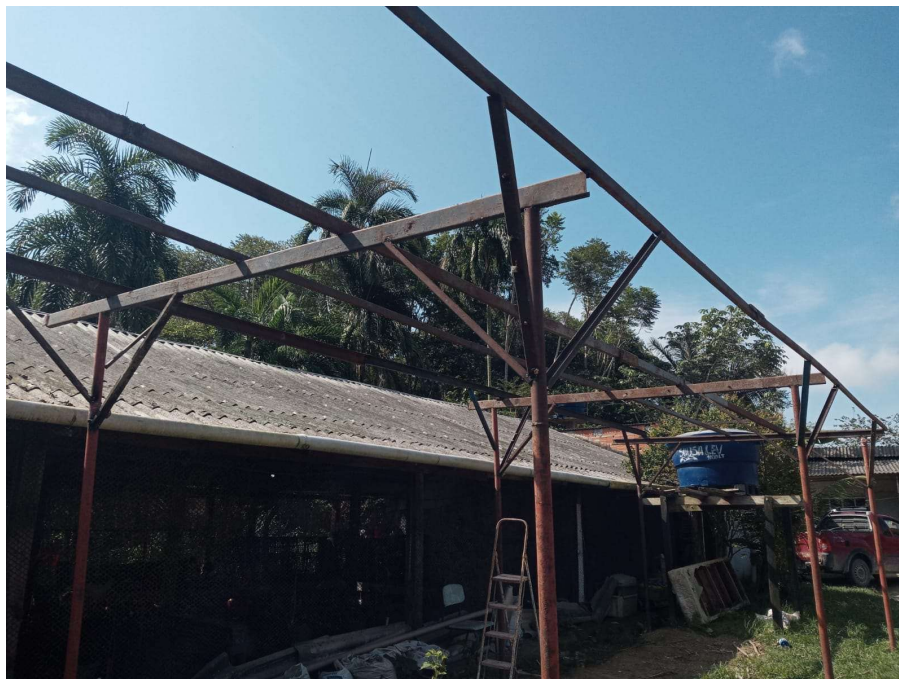
Figura 21 – Estrutura Metálica para fixação dos painéis Fotovoltaicos.
