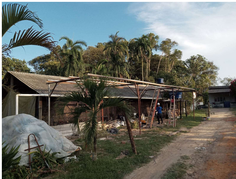
Figura 20 – Estrutura Metálica para fixação dos painéis Fotovoltaicos.
