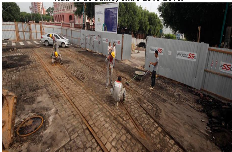
Figura 27: Obras de revitalização da Avenida Eduardo Ribeiro (trecho do cruzamento com a Rua 10 de Julho) entre 2015-2016.
