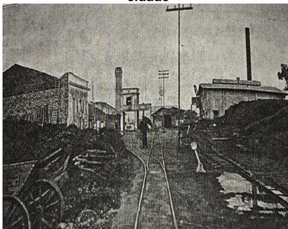
Figura 7: Estação dos bondes e postes de eletricidade que forneciam energia elétrica para a cidade
