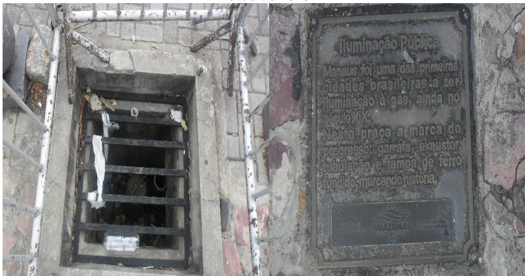
Figura 47: Compartimento que abriga a tubulação (à esquerda) e placa informativa (à direita). Fotos de 2019.
