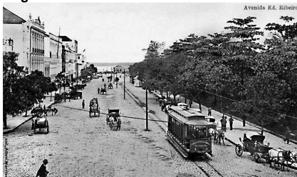
Figura 20: Avenida Eduardo Ribeiro sem data
