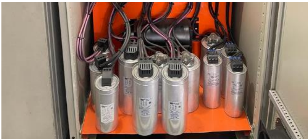
Figura 13: Capacitores em paralelo
