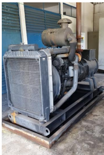
Figura 15 : Gerador 180 kVa
