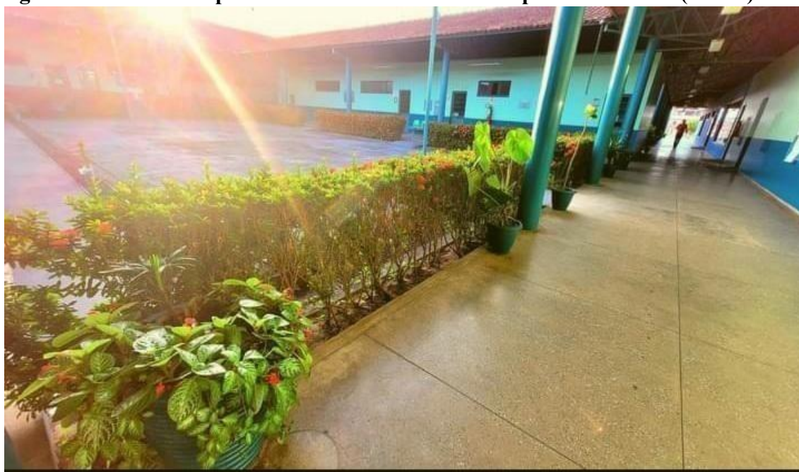
Figura 18. Interior do prédio do Centro de Estudos Superiores de Tefé (CEST).
