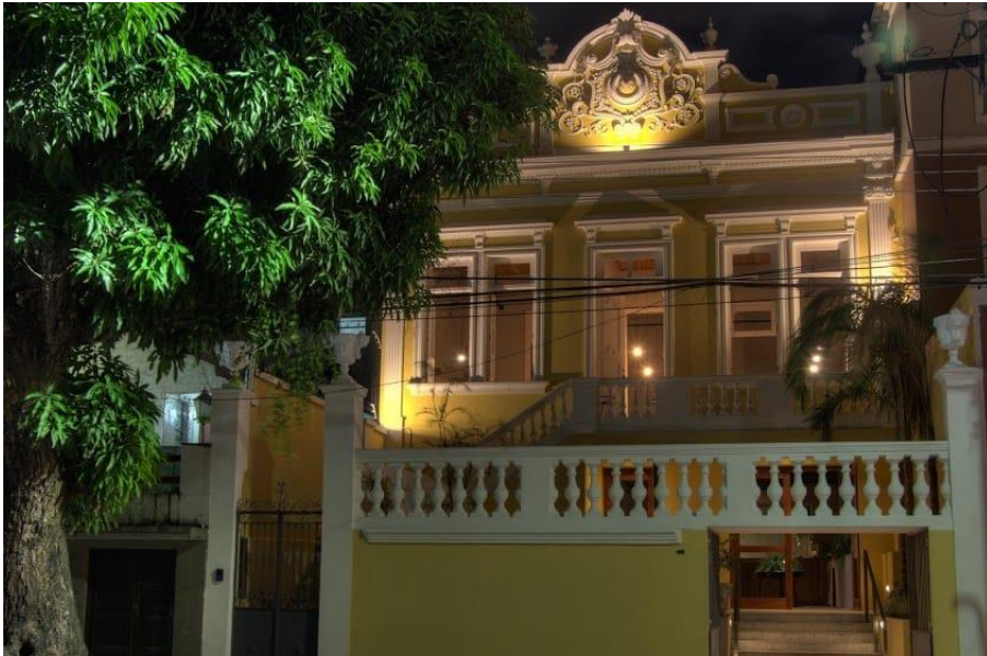
Figura 21 – Fachada do restaurante FitzCarraldo Bistrô
