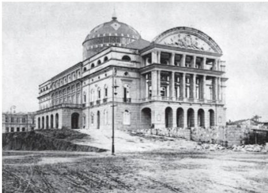
Figura 3 – Teatro Amazonas, rampas de acesso ainda em construção
