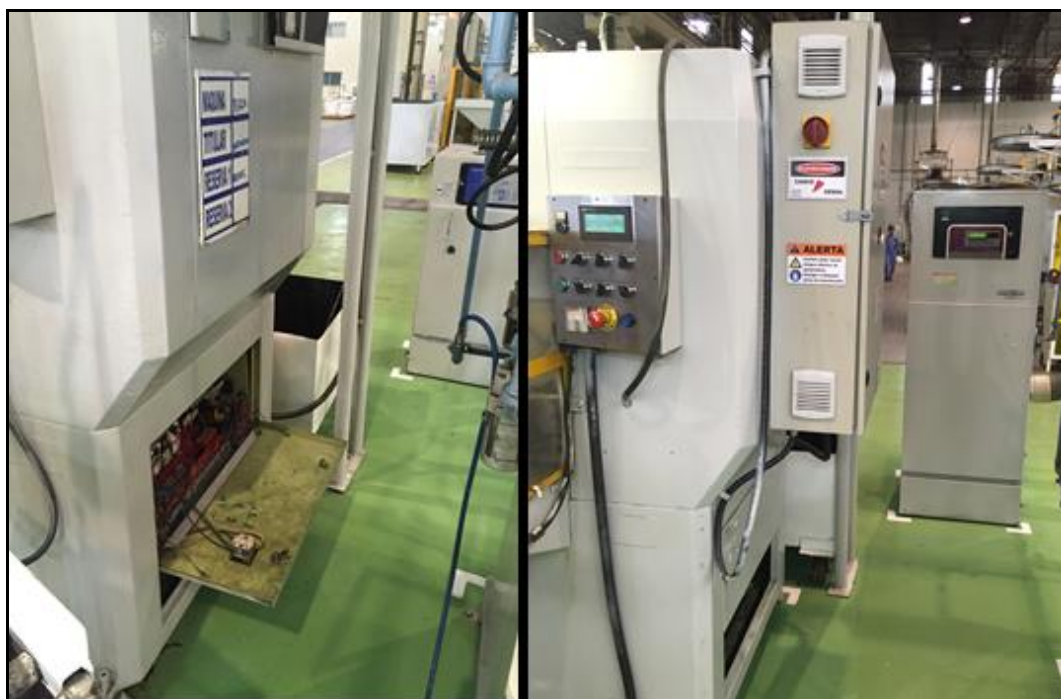
Figura 20 – Localização do antigo e do novo painel elétrico da máquina.
