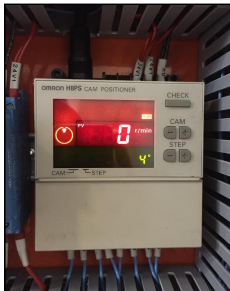
Figura 25 – Decodificador do encoder instalado no painel.
