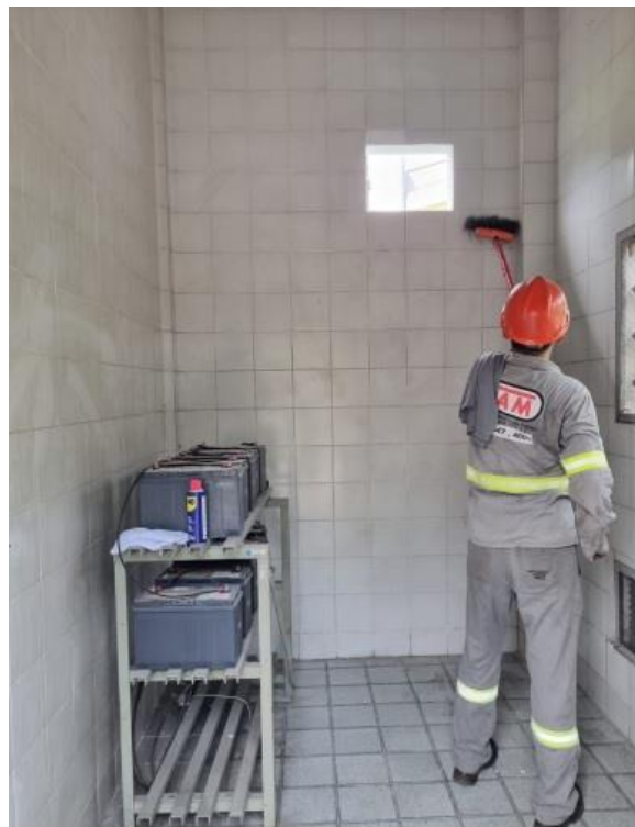
Figura 35 – Manutenção na Sala de Baterias
