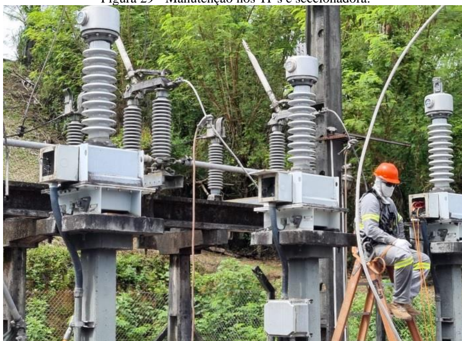
Figura 29 - Manutenção nos TP's e seccionadora.
