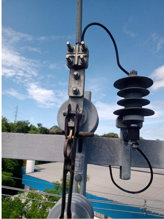
Figura 40 - Manutenção: Conector e cabo após substituição
