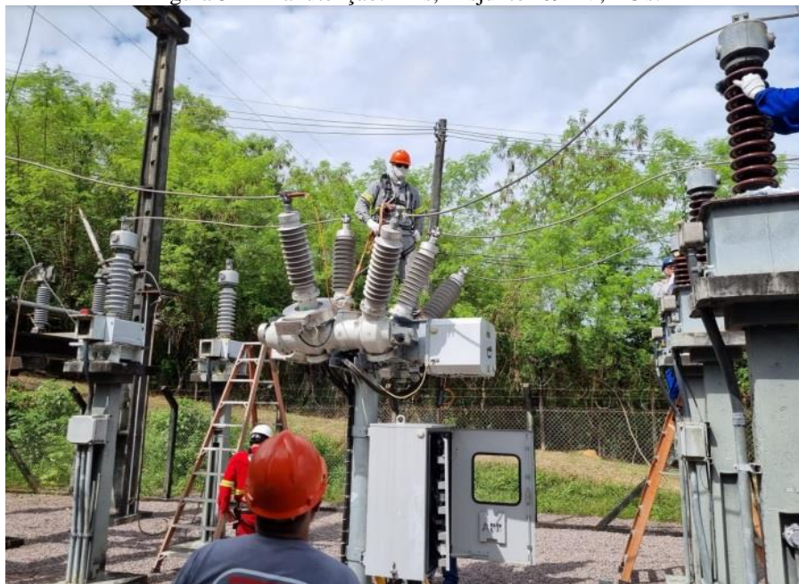
Figura 31 - Manutenção: TP's, Disjuntor 69 kV, TC's.
