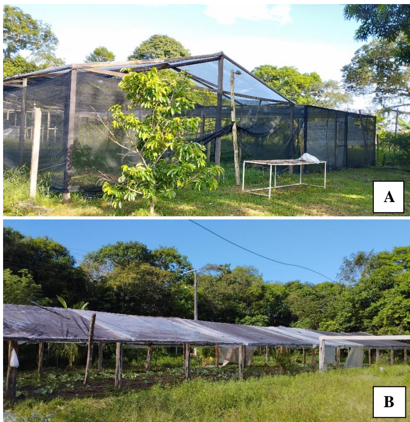
Figura 3 - Propriedade Rural Parintins, casas de vegetação com revestimento na lateral e cobertura com tela sombrite em (A); casa com cobertura plástica transparente sem proteção lateral em (B).
