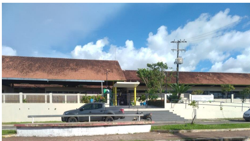
Figura 01: fachada da escola Dom Gino Malvestio. Fonte: FONSECA, 2022.
