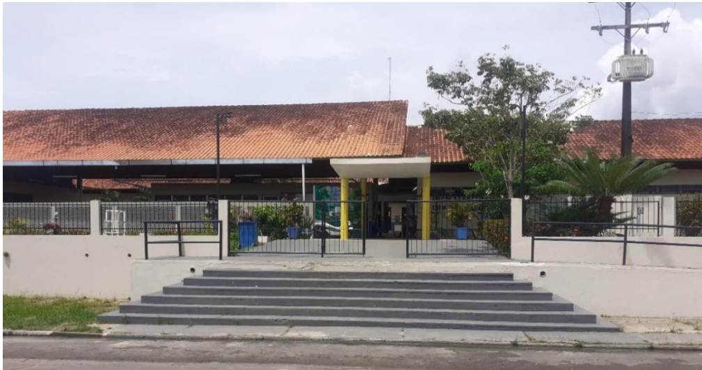
Figura 01: Escola Estadual Dom Gino Malvestio. Fonte: Ádria Trindade, (2022).
