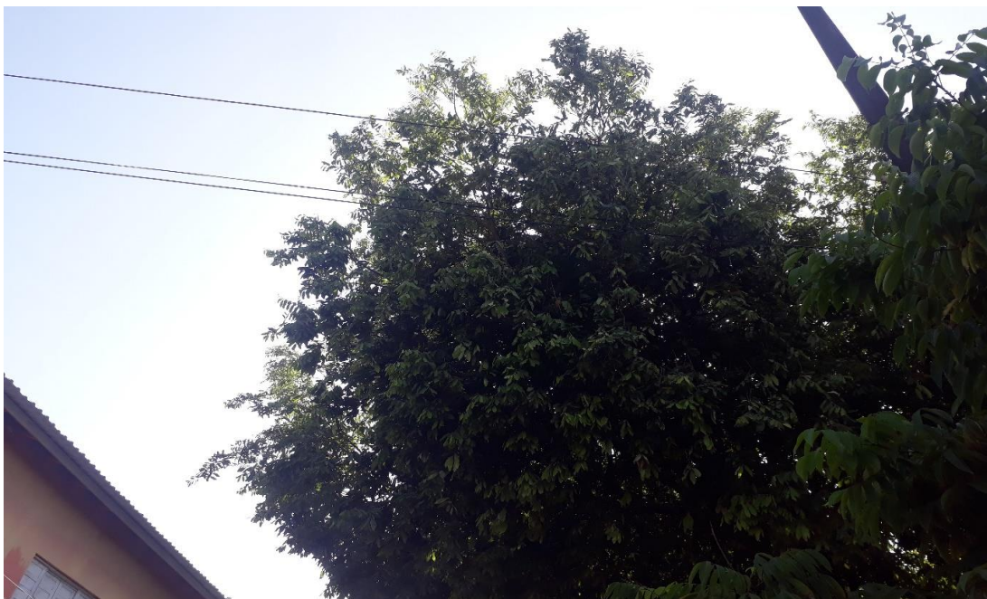
Figura 4: Copa de árvore envolvendo a fiação elétrica.
