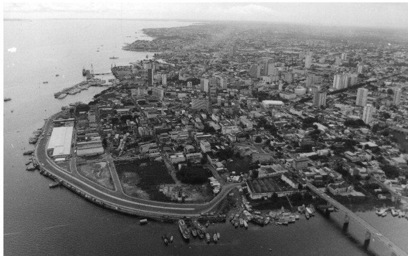
FIGURA 4: CONSTRUÇÃO AVENIDA LOURENÇO DA SILVA BRAGA, DÉCADA 80.
