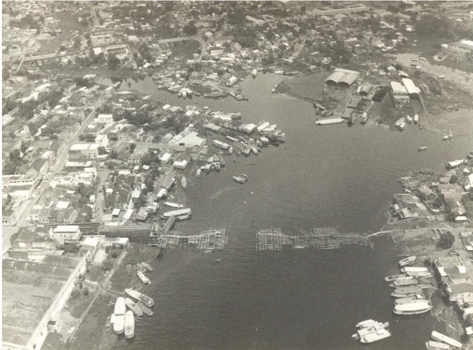
FIGURA 15: CONSTRUÇÃO DA PONTE ANTÔNIO PLÁCIDO DE SOUZA.
