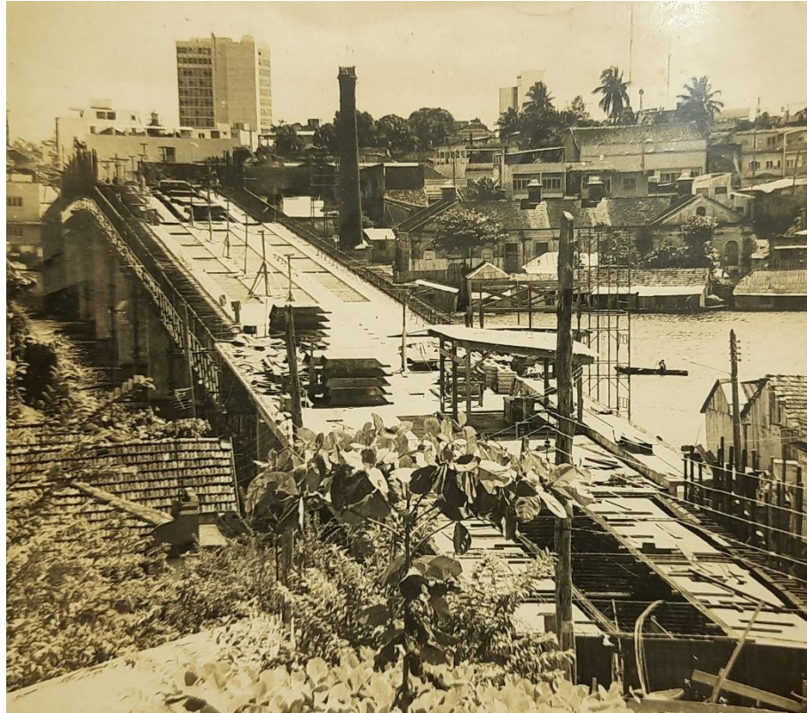
FIGURA 16: CONSTRUÇÃO DA PONTE ANTÔNIO PLÁCIDO DE SOUZA.
