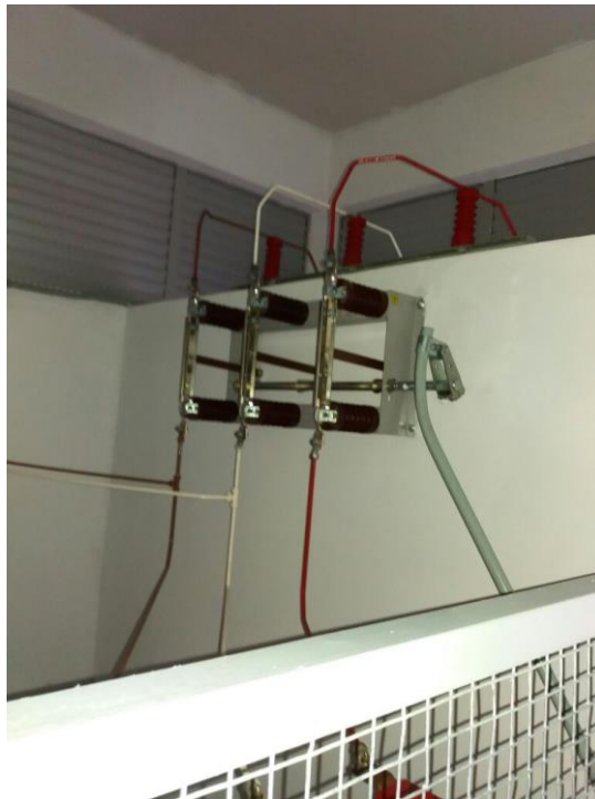
Figura 5 – Chave Seccionadora tripolar 15 kV de 200 A (Super Terminais).
