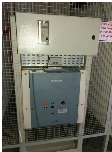
Figura 10 – Disjuntor de média tensão SIEMENS tripolar a Vácuo 15 kV 1250 A.
