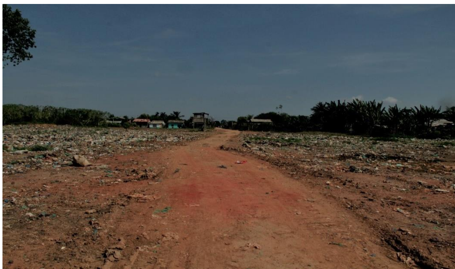
Figura 03: Área do depósito de lixo na cidade de Barreirinha, no Estado do Amazonas.
