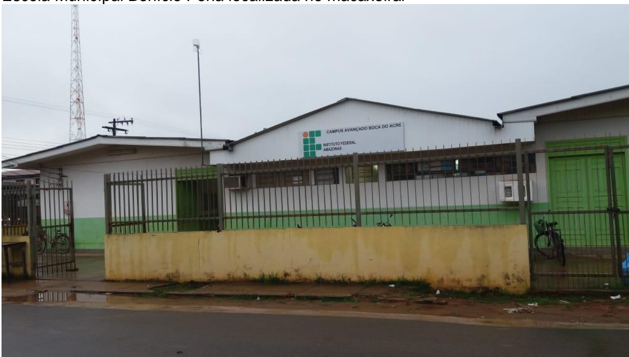
Escola Municipal Benício Pena localizada no macaxeiral
