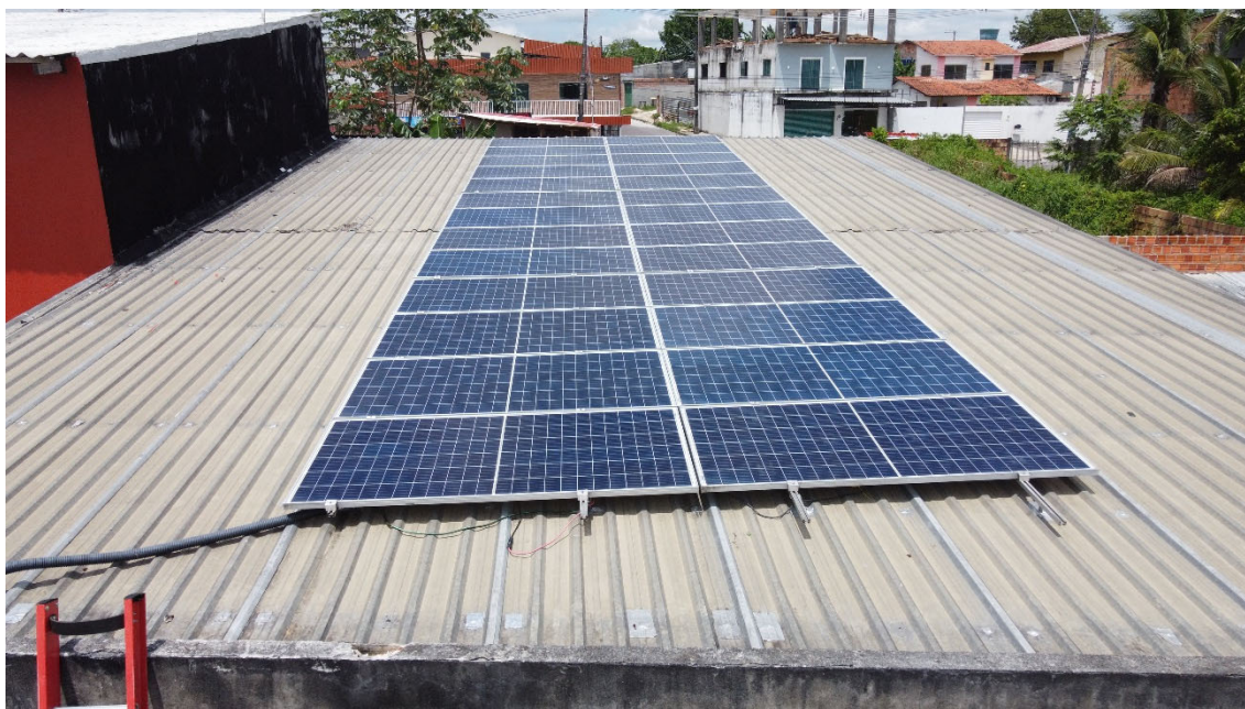
Figura 16 - Vista frontal UFV
