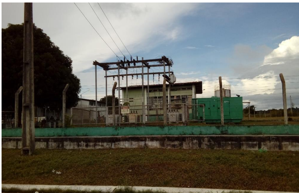
Figura 7: Abastecimento de energia elétrica. Fonte: Pesquisa de Campo, 2009 (Charlene Muniz).
