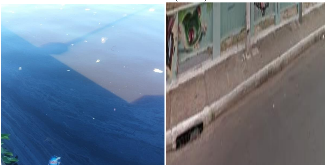
Figura 15: Águas do Igarapé de Educandos tomada por óleo jogado das embarcações (à esquerda); Bueiro que desagua no Igarapé de Educandos/ Avenida Lourenço Braga- Manaus Moderna próximo ao Centro Cultural Usina Chaminé (à direita)
