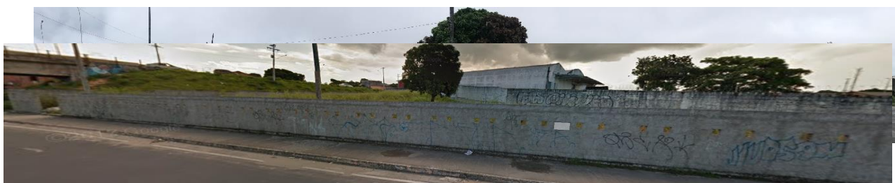
Figura 2- Muro antes de intervenção artística. Fonte: Google Street View. Acesso em 10 de abril de 2019
