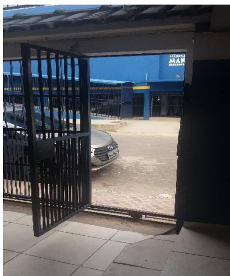
Figura 1: Fachada do CMEI
