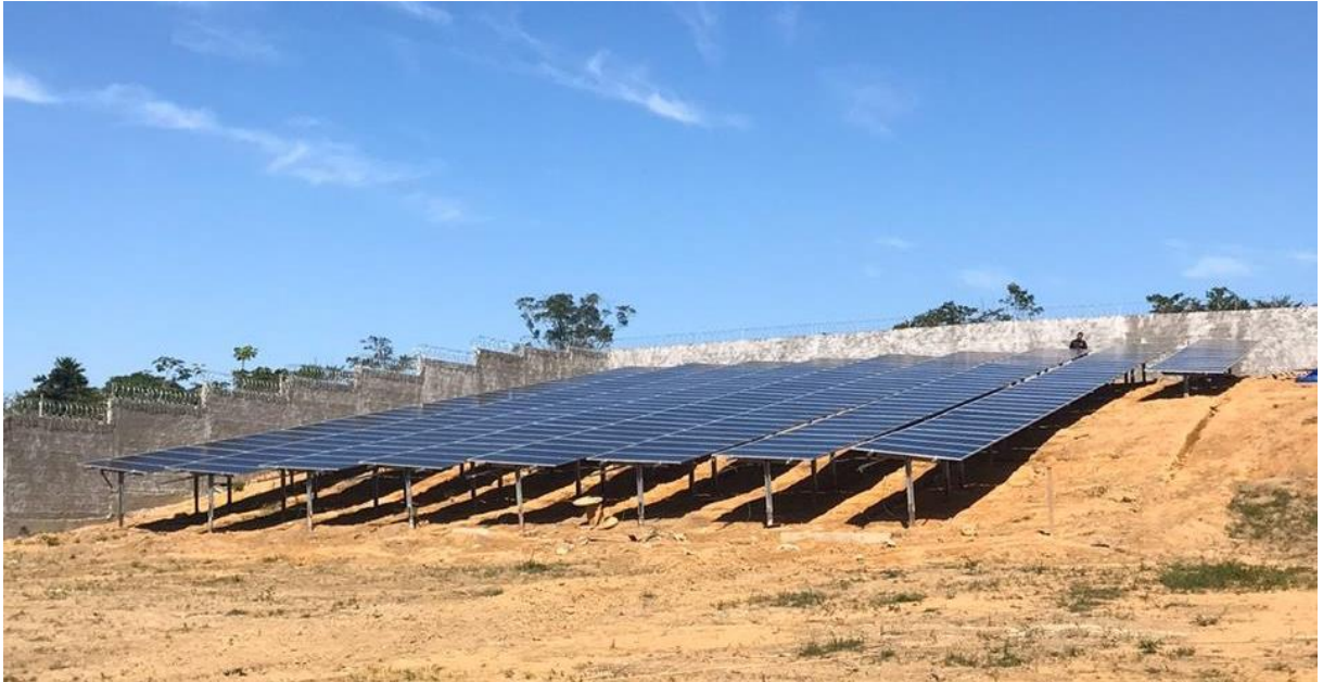
Figura 22 Duzentos E Setenta Painéis Instalados Na Parte Alta Do Lote 64
