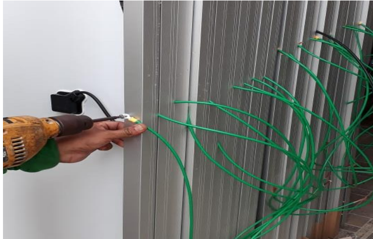
Figura 13 – Parafusar o ponto de aterramento na moldura dos painéis fotovoltaicos
