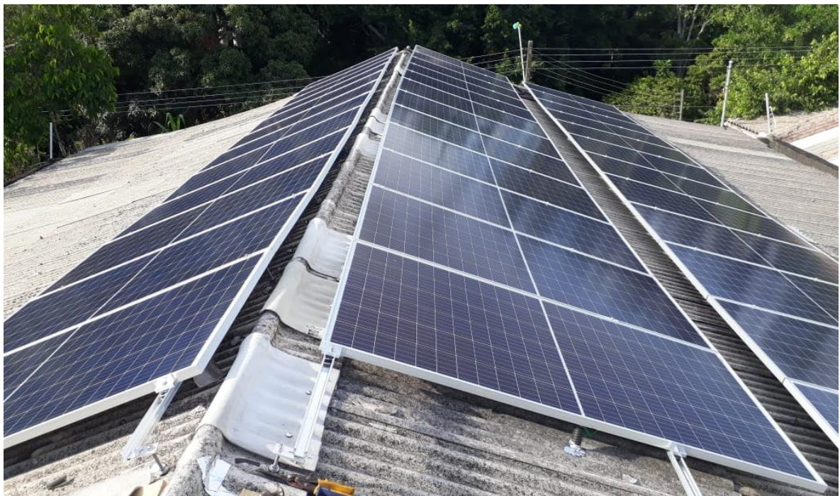
Figura 16 – Os módulos do arranjo MPPT1 e MPPT2 do sistema solar
