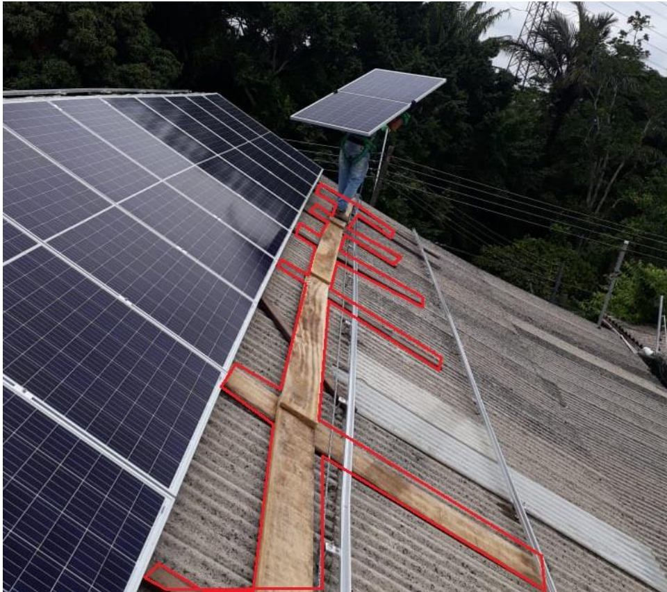
Figura 10 – Andaime de tábua de azimbre sobre o telhado
