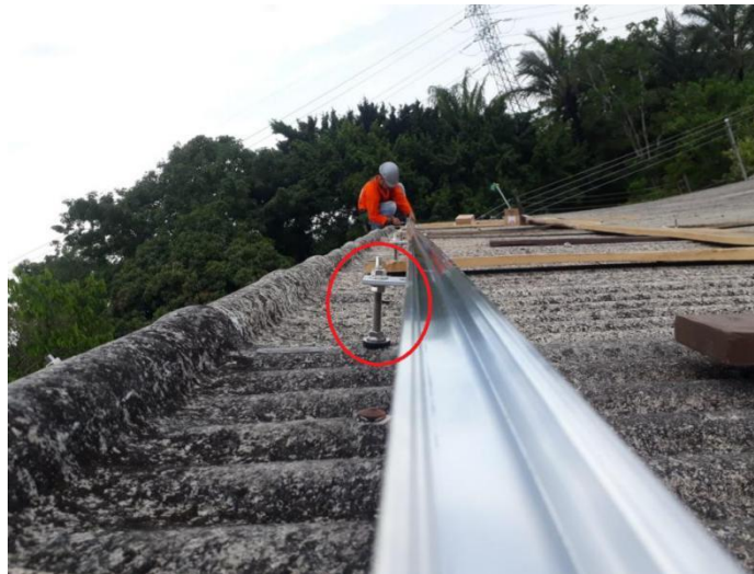
Figura 12 – Fixação dos trilhos / Perfil H sobre os fixadores
