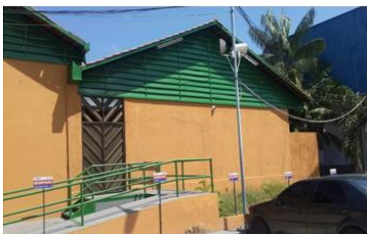
Figura 1: Fachada sede do Centro de Mídias Fonte: Pesquisadora 2018
