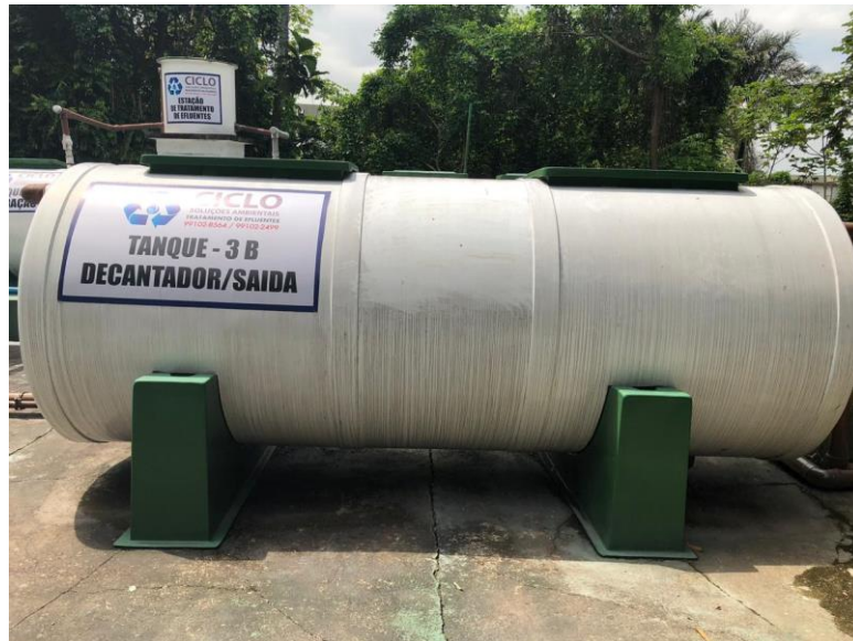
Figura 10. Tanque referente a etapa de decantação.
