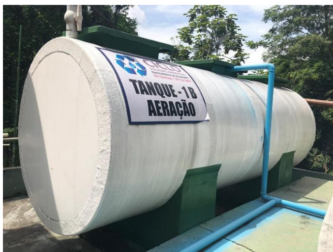
Figura 9. Tanque de Aeração que corresponde a etapa anaeróbia e aeróbica
