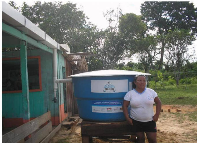
Figura 21: Reservatório de fibra de vidro – PROCHUVA
