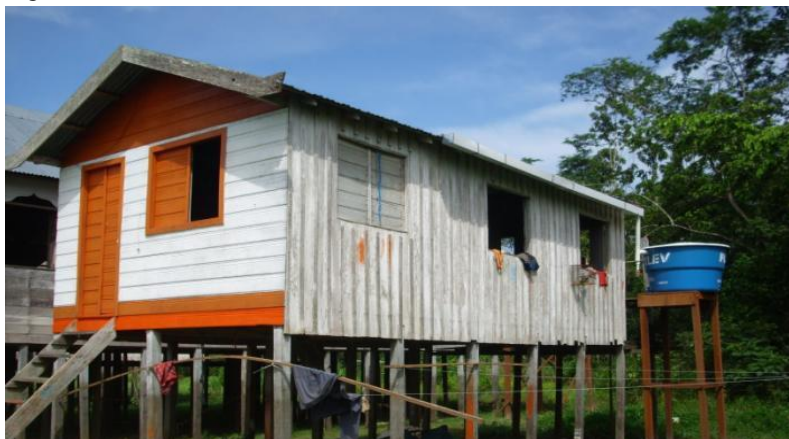
Figura 12 - Sistema domiciliar – Instalado em área de várzea
