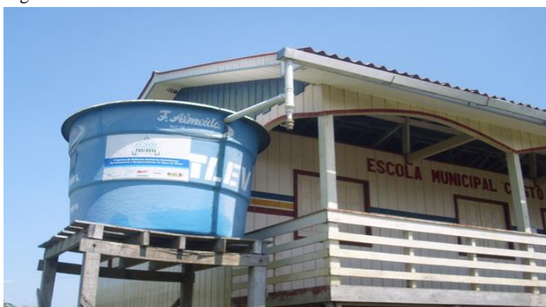
Figura 13 - Sistema Comunitário - Instalado em uma escola
