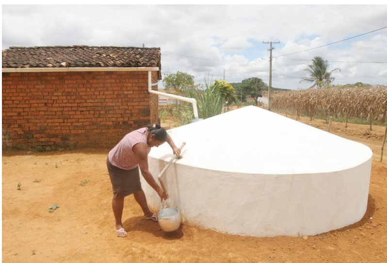
Figura 11 - Cisternas do Programa Um Milhão de Cisternas
