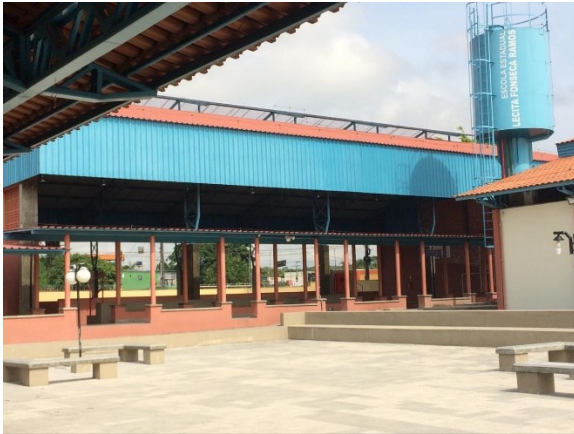
Foto 1 – Praça Central da Escola
