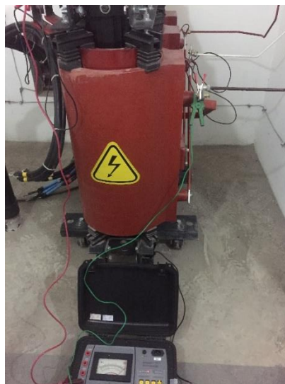
Figura 3: Ensaio de medição da resistência de isolamento
