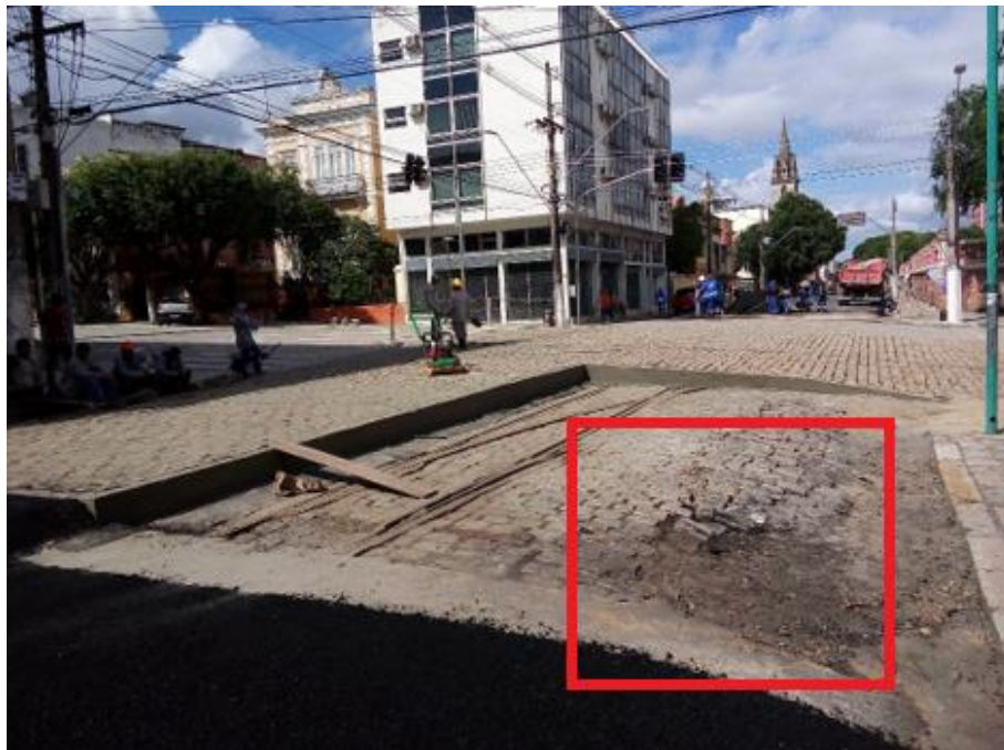
Figura 35. Janela do trilho, área de recomposição de paralelepípedos AV.10 de Julho. Fonte: AUTOR, 2016.
