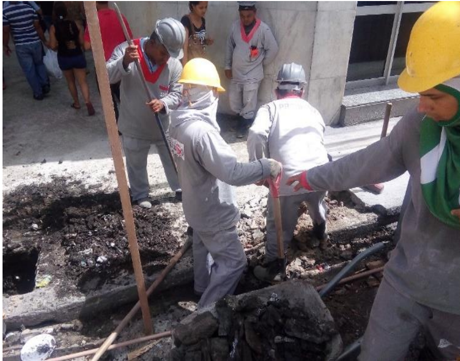
Fig.21. Demolição das calçadas. Fonte: AUTOR,2016.
