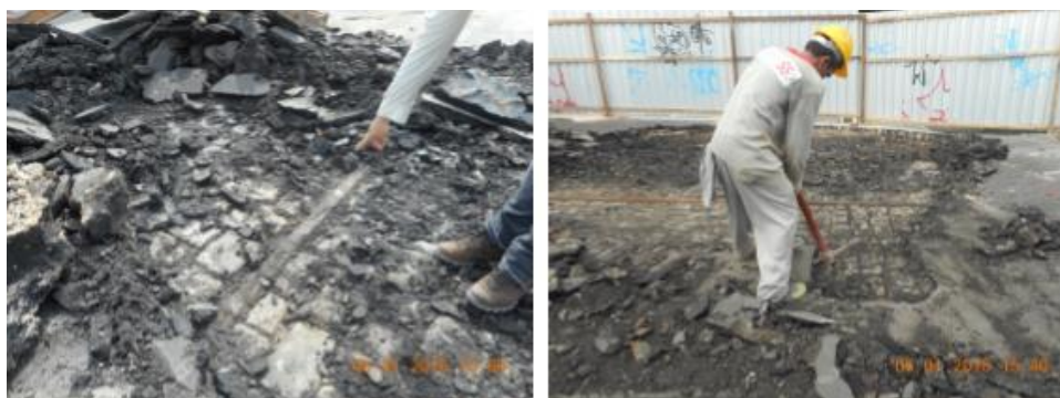
Fig. 30. Remoção da camada de asfalto de forma manual. Fonte: CERQUEIRA & BENEDITO, 2016.
