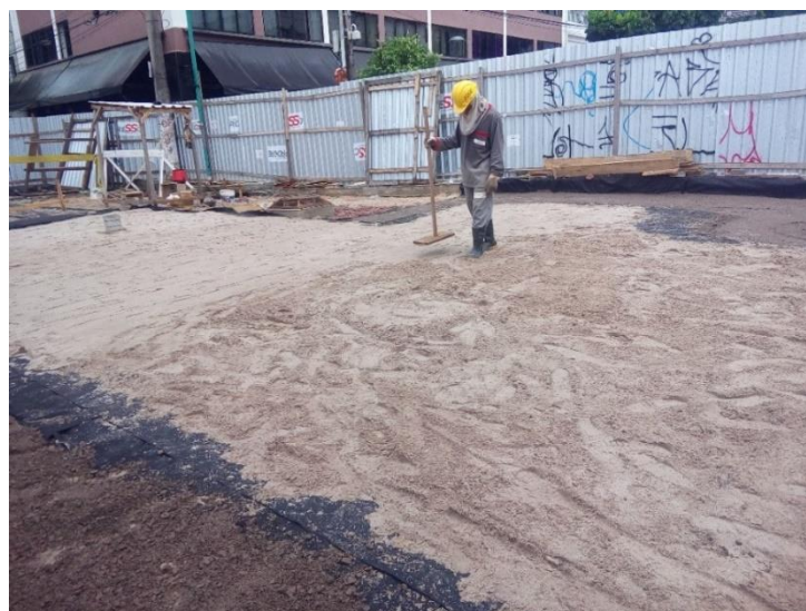
Figura 34. Área dos trilhos na rua. 10 de Julho sendo coberta.
