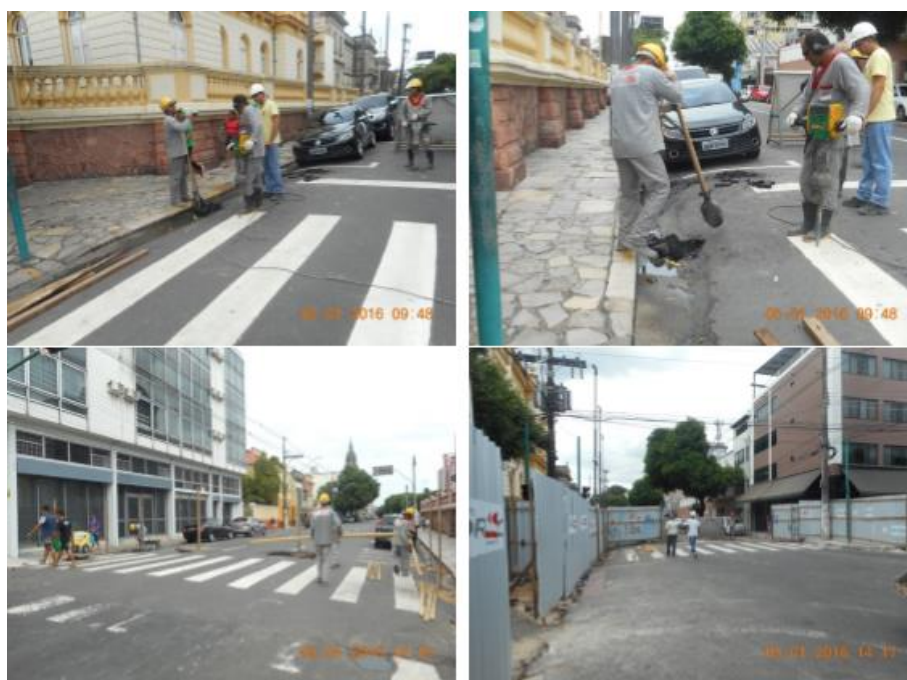
Fig. 27. Instalação do tapume na Avenida 10 de Julho. Fonte: CERQUEIRA & BENEDITO, 2016.
