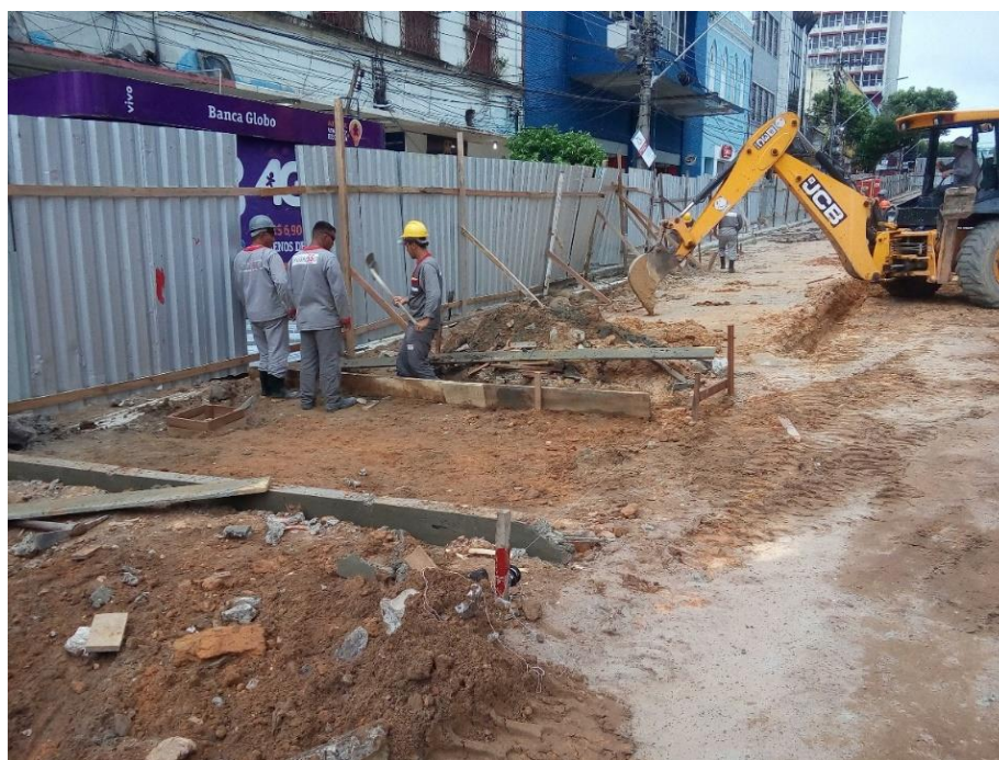
Fig. 18 –retroescavadeira nivelando o terreno Fonte: AUTOR, 2016.
