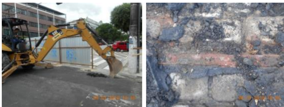
Fig. 29. Remoção da camada de asfalto com retroescavadeira e evidência do trilho e paralelepípedos. Fonte: CERQUEIRA & BENEDITO, 2016.
