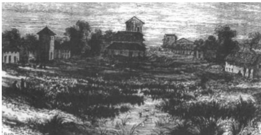
Fig. 04 - Vista parcial da Vila da Barra do Rio Negro, a partir dos Remédios: note-se a precariedade do lugar, com ausência de pavimentação e predomínio de construções baixas e simples. Fonte: MARCOY, Paul. 2001.
