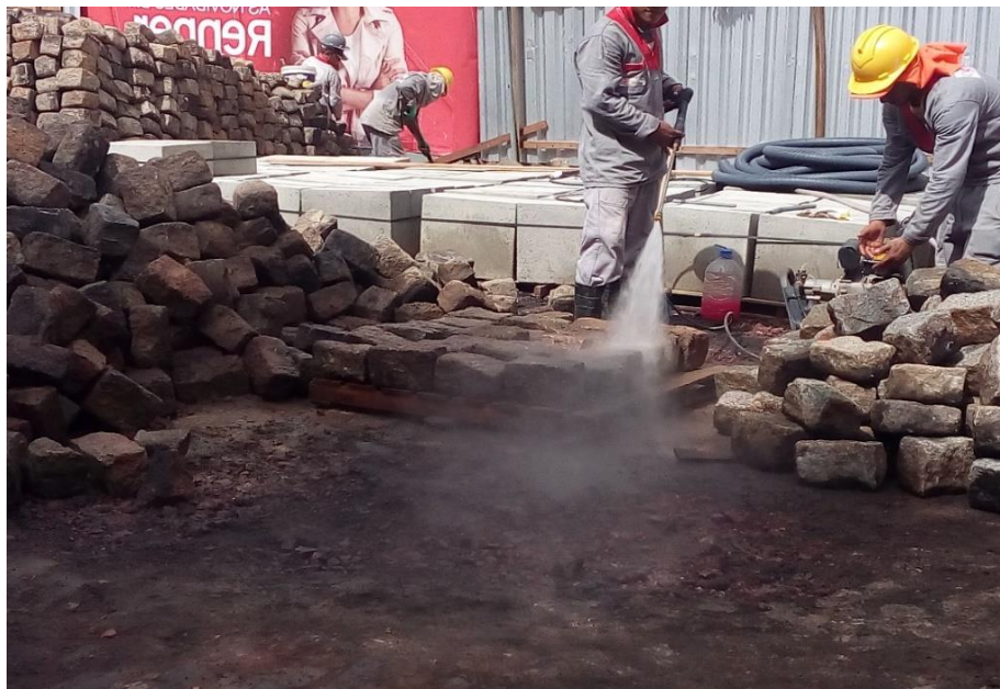
Fig.20. Lavagem manual de paralelepípedos. Fonte: AUTOR,2016.
