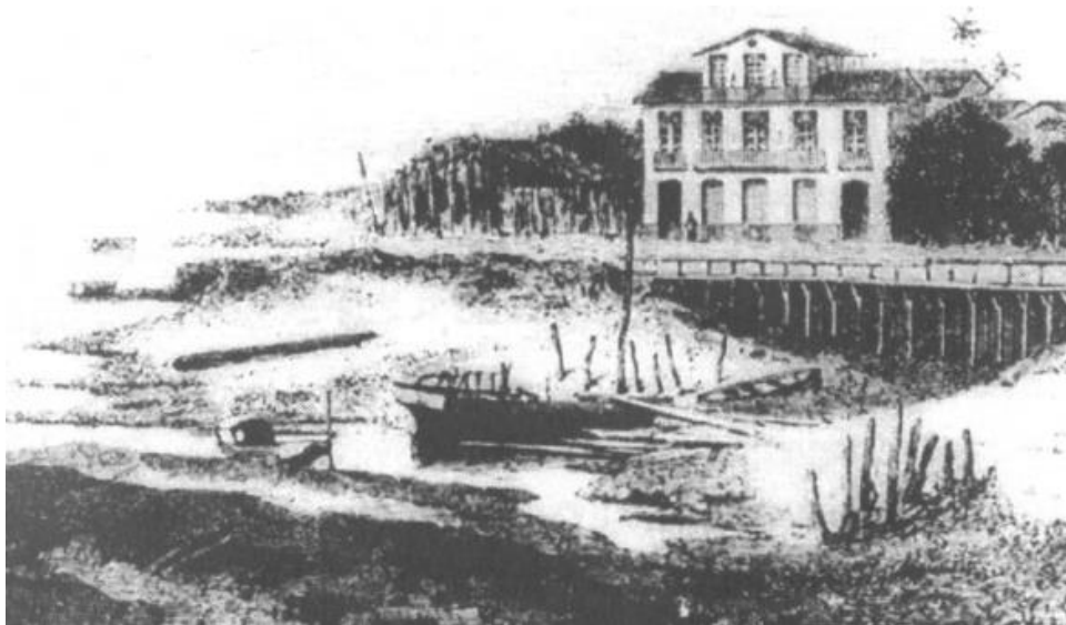
Fig. 06 – Palácio da Presidência da Província do Amazonas. Mesmo esta importante edificação traz a tipologia simplória predominante nas demais construções. Fonte: BIARD, 2004.
