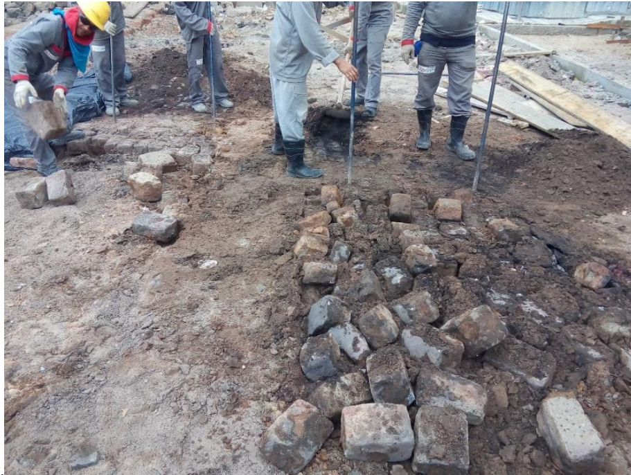
Fig.19. Retirada manual de paralelepípedos. Fonte: AUTOR,2016.
