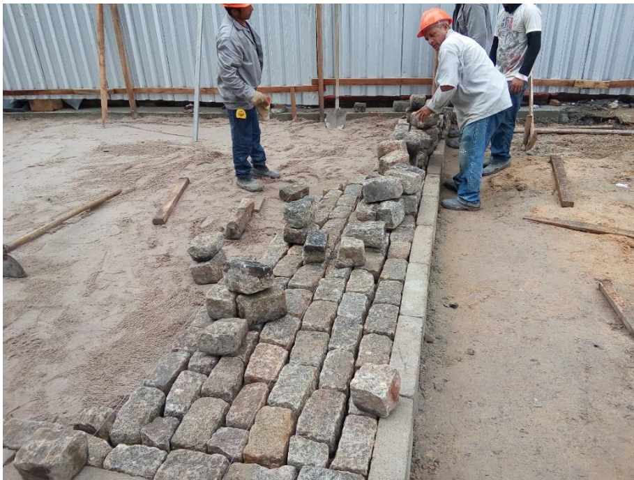
Fig.22. Reassentamento manual de paralelepípedos. Fonte: AUTOR,2016.
