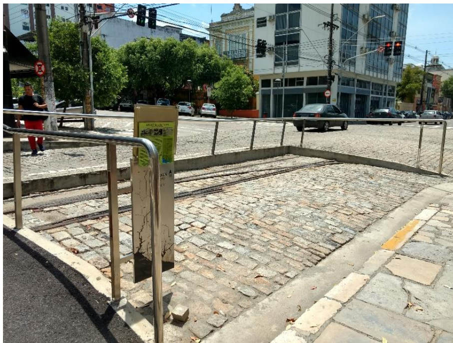
Figura 36. Janela do trilho, área entregue AV.10 de Julho. Fonte: AUTOR, 2017.
